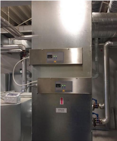
Le unità di trattamento dell'aria (UTA) avanzate, dotate di **dispositivi UV-C**, sono progettate per regolare la temperatura, il flusso d'aria e l'umidità, creando le condizioni ambientali precise necessarie per processi come la **frollatura a secco** e la **conservazione a freddo**.
