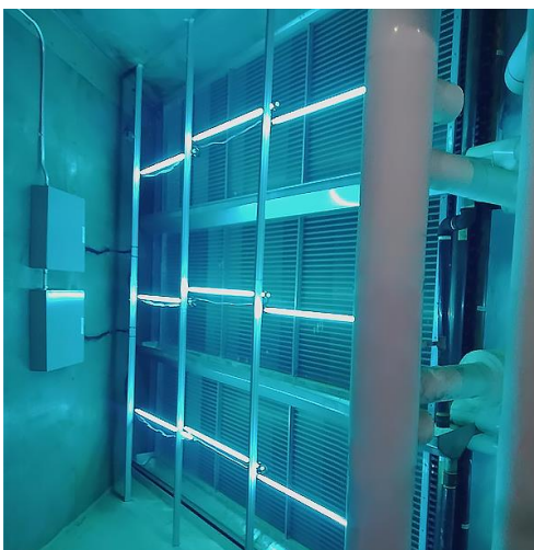
Esempi di diverse applicazioni dei prodotti Light Progress per il trattamento dell'aria in una U.A.H., un depuratore d'aria in una serra e un'installazione in sistema di ventilazione.
