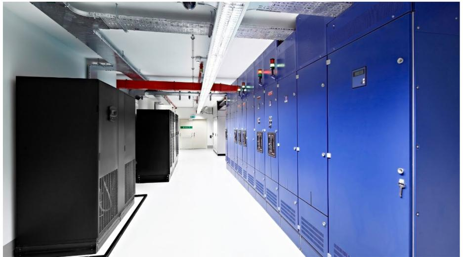
\* **I sistemi di In-Row Cooling** posizionano le unità di raffreddamento direttamente tra le rack dei server, riducendo la distanza che l'aria fredda deve percorrere per raggiungere le apparecchiature. Questo metodo è energeticamente efficiente poiché concentra il raffreddamento dove è più necessario.
