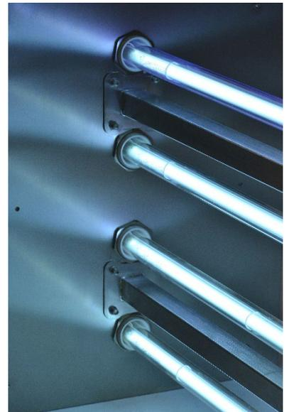
Ulteriori ricerche da parte della **Penn State University** hanno confermato che la luce **UV-C** è efficace nel rimuovere microrganismi, migliorando la **capacità di trasferimento del calore** e riducendo i consumi energetici.
