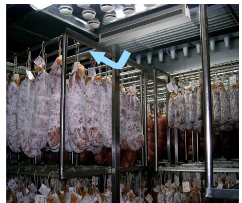
Anwendung in einem Kühlraum
